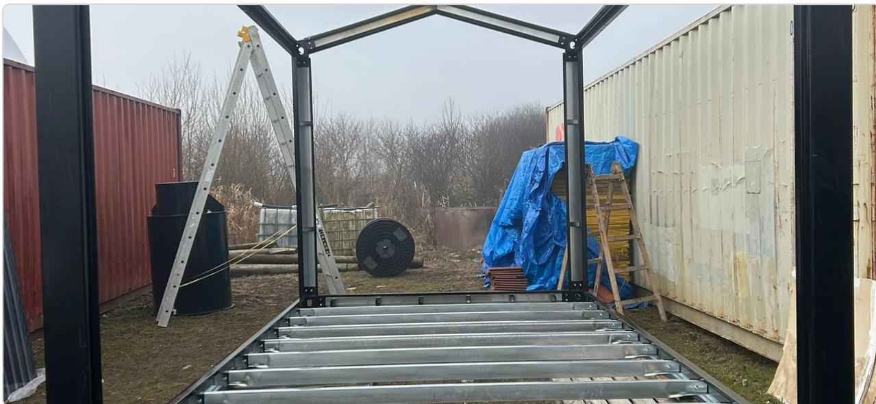
Zostavený spodný rám s podlahovými nosníkmi
