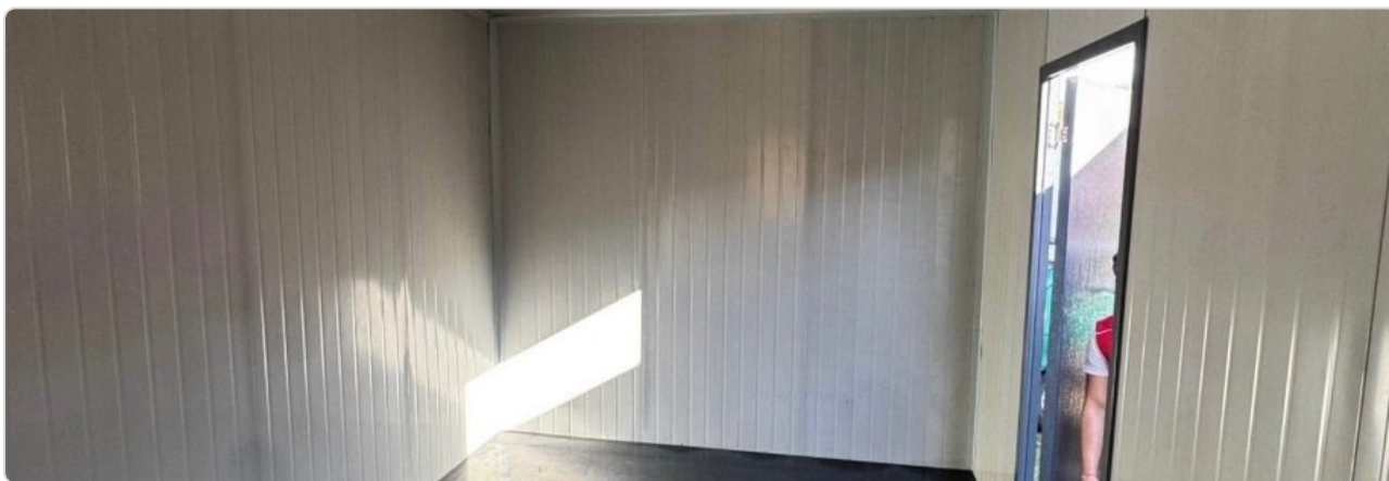
Interiér kontajnera pripravený na položenie podlahy
