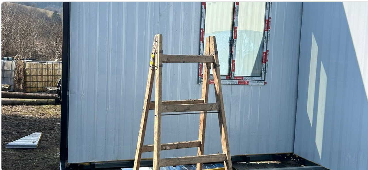
Montáž sendvičových stien na krátkej strane kontajnera
